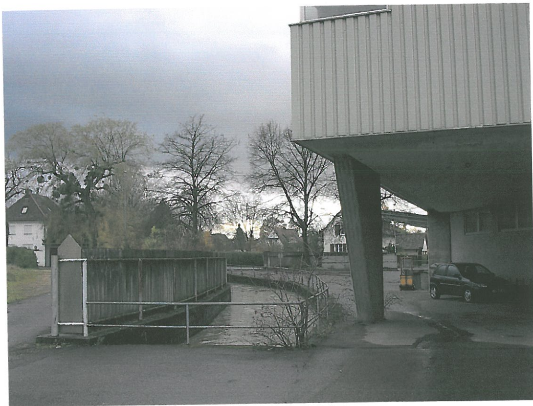
Der westliche Bereich des Planungsgebietes mit Mühlkanal und Industriebebauung
