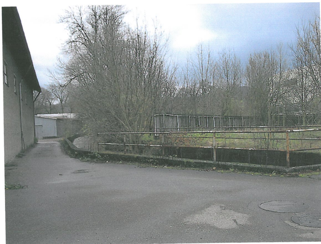
Der Mühlkanal außerhalb des Geltungsbereiches am nördlichen Rand des Gebietes
