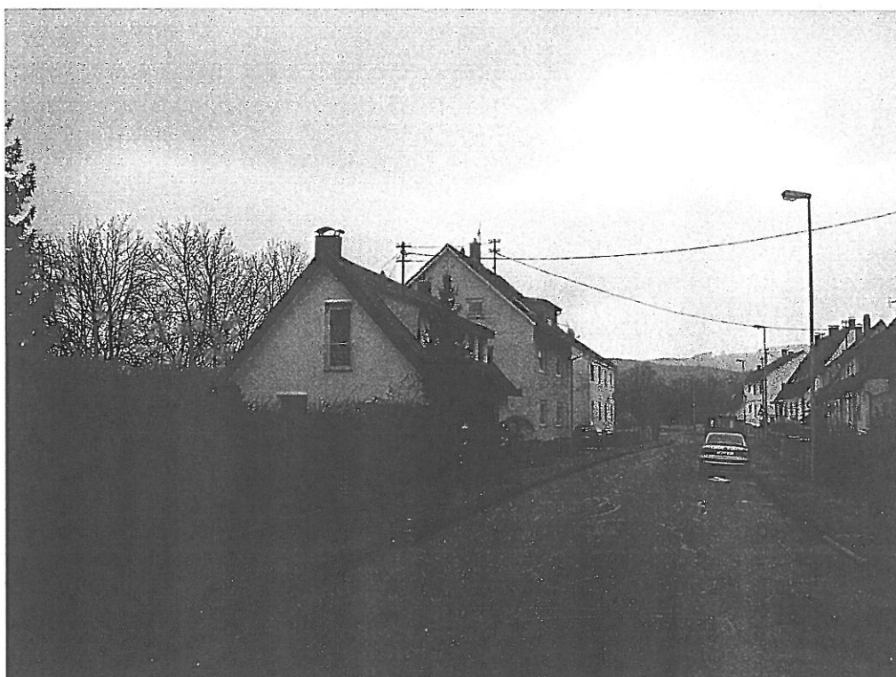
Die Jahnstraße in östlicher Richtung; links: Gebäudebestand (Allgemeines Wohngebiet)
