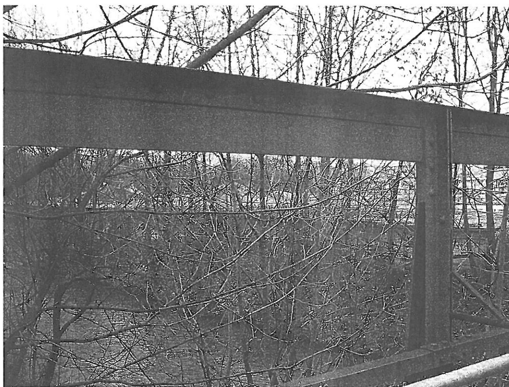
Die Mauer des Installationskanals entlang des künftigen Mischgebiets (Blick vom Filssteg flussaufwärts)
