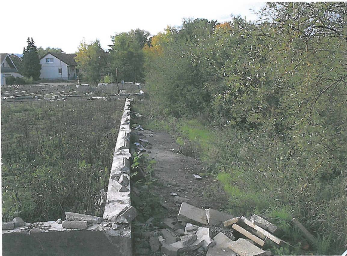
Die Uferzone des Schweinbaches (rechte Bildseite) , Fundamente und Abrissmaterial
