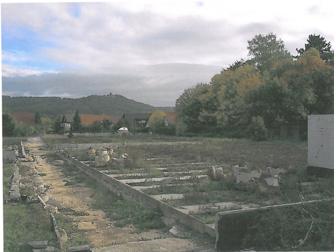
Die Abbruchbereiche der ehemaligen Gärtnereigebäude im Süden des Gebietes
