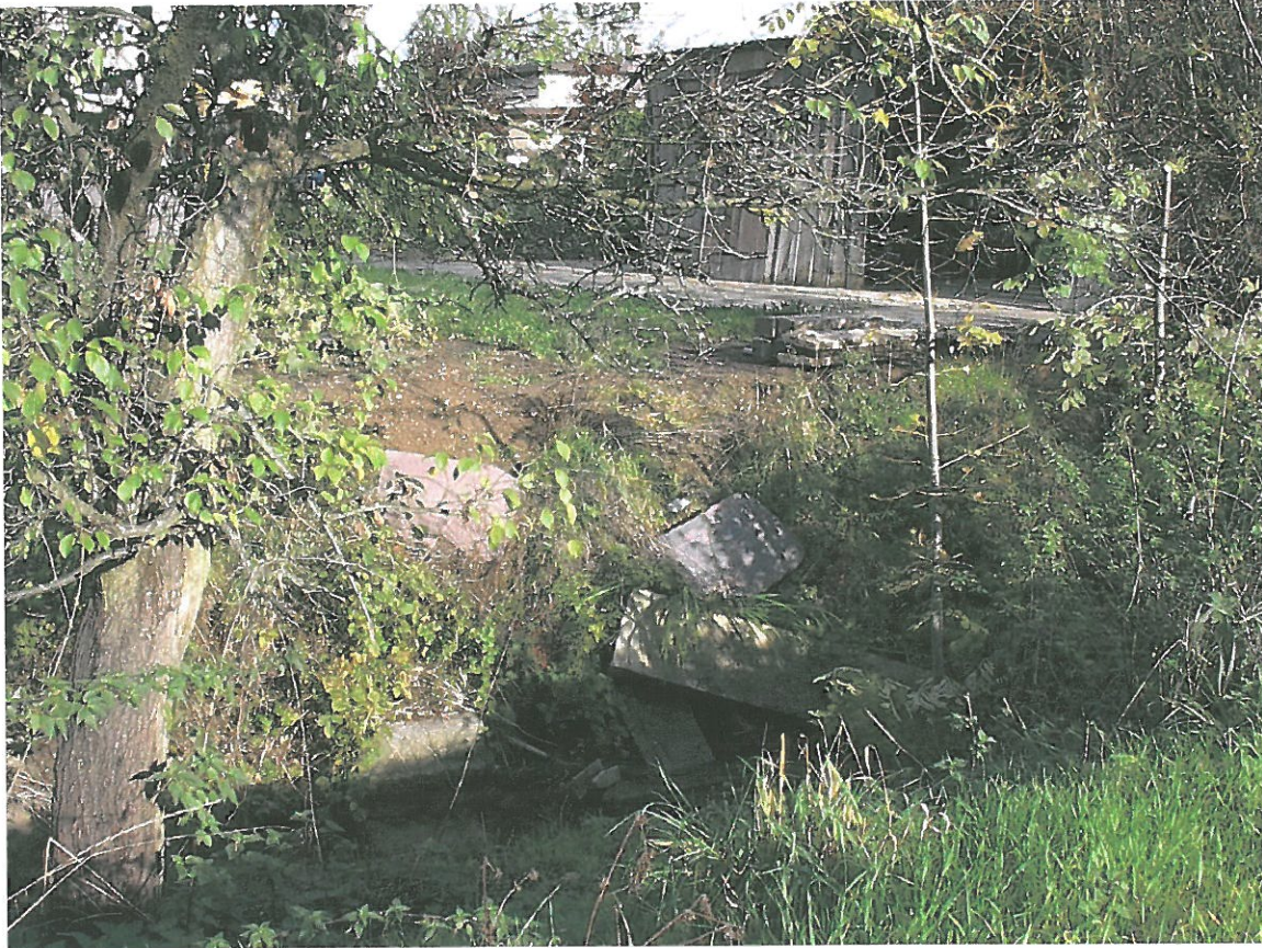
Das Ufer des Schweinbaches mit standortfremder Vegetation und Abbruchteilen
