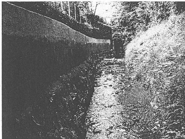
Abbildung 3: Ufermauer entlang der Gärten
