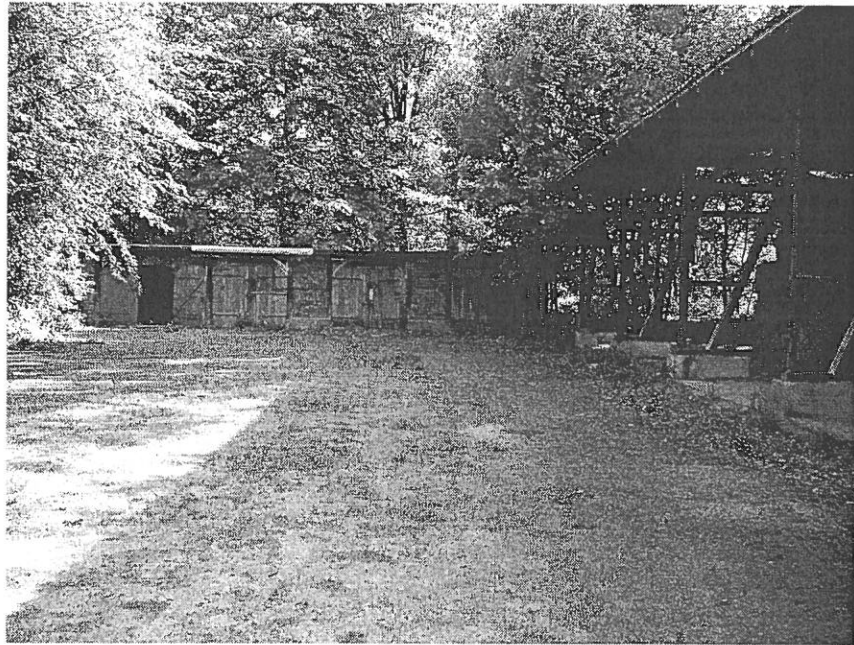
Bild 7: Hoffläche östlich der Bergehalle mit baufälligen Garagen. Foto: Koch, 2008
