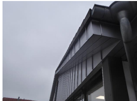
Abbildung 4: Dachvorsprung und Regenrinne mit Quartierpotenzial.
