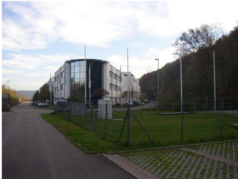
Abbildung 3: Blick auf das beplante Gebiet
