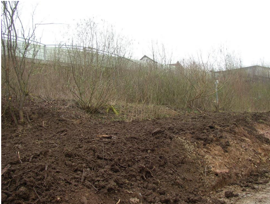
Abb 1: Die Fläche ist rekultiviert und mit Oberboden bedeckt. Die entnommenen Strauchgehölze aus dem Baufeld für die Erschließungsstraße wurden in die Böschung gesetzt
